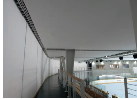
Decke und Wände - Eislaufhalle Vaujany (FR)
